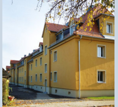
Mehrfamilienhausbebauung im Siedlungsviertel, Naumburg (Saale) statische und energetische Ertüchtigung und Sanierung Gebäudehülle
