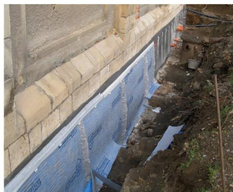
Schadhafte Fugen wurden mindestens 2 cm ausgeräumt und mit Grundputz wieder geschlossen.
